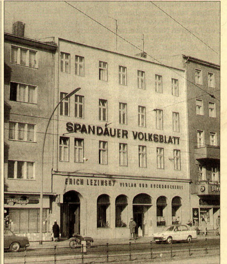
Die neugestaltete Fassade des Verlagsgebäudes in der Neuenfelder Straße 101 in den sechziger Jahren.
